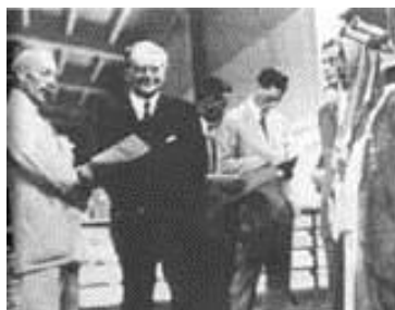
Открытие гидростанции в Нахараиме.
